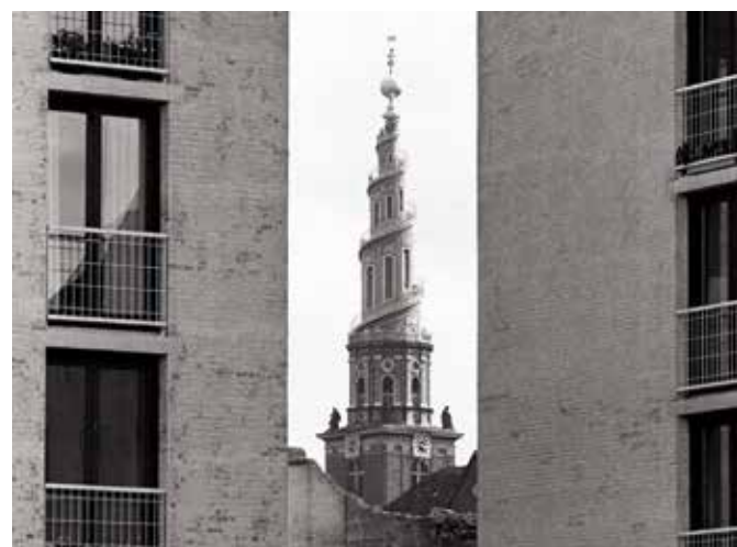
Beton. Vor Frelser Kirke. 1977.
