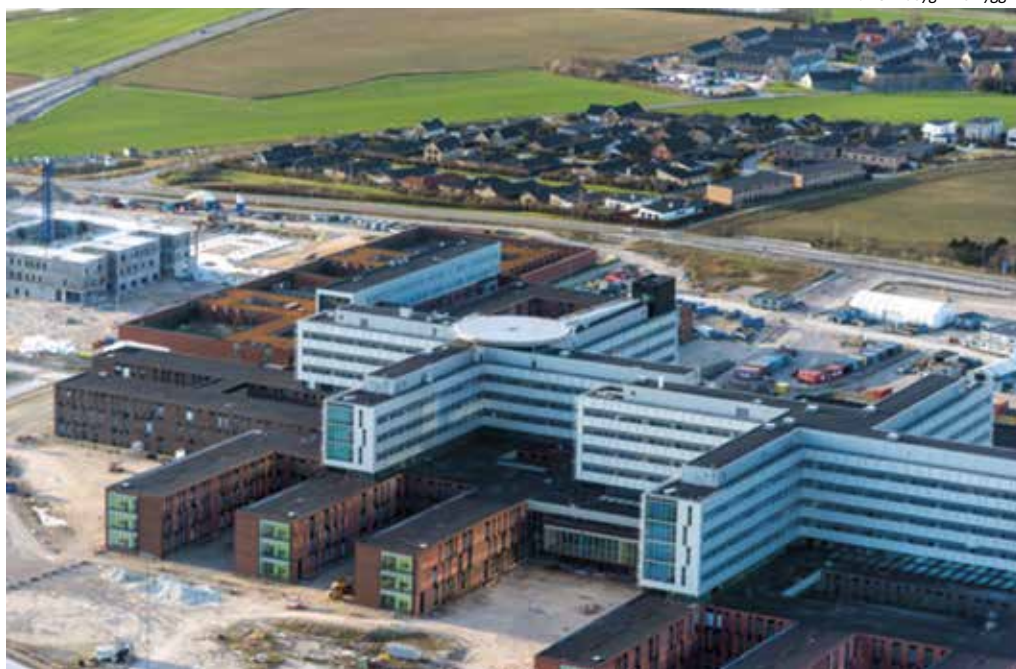
Foto Godt sygehus byggeri
